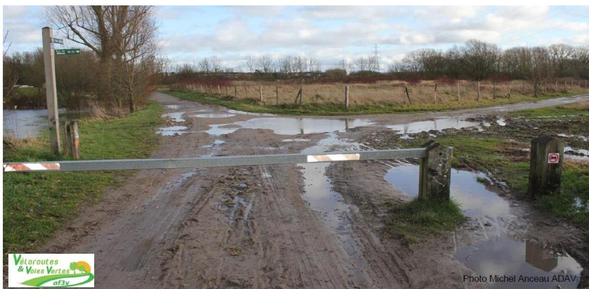
Exemple d'une voie verte en stabilisé, fortement dégradée par les intempéries. Source : Association Française des Véloroutes et Voies Vertes (AF3V)
