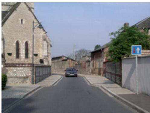
Écluse avec rétrécissement axial
