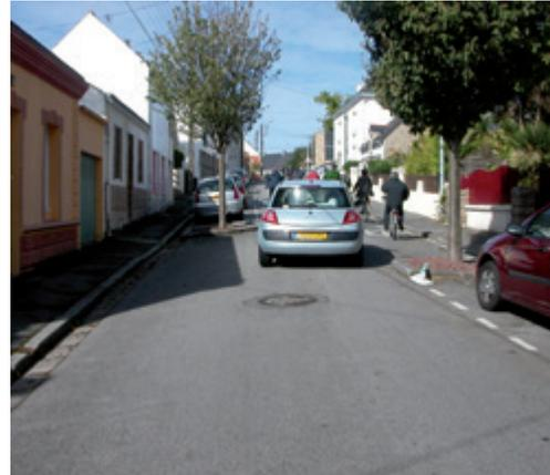
*Chicane sans îlot central implantée dans une zone 30. Des pictogrammes vélos marqués sur la chaussée sont recommandés pour matérialiser le double-sens cyclable.*
