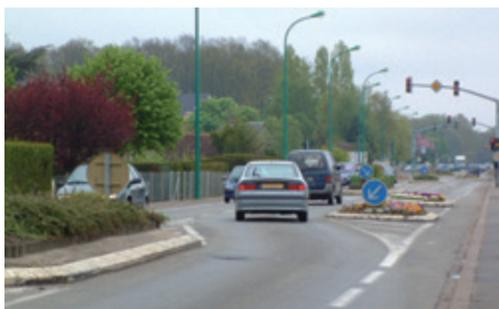
Un bon niveau d'adhérence et d'entretien de la chaussée est nécessaire afin de garantir l'équilibre des conducteurs de deux-roues motorisés lors du franchissement de l'aménagement.
