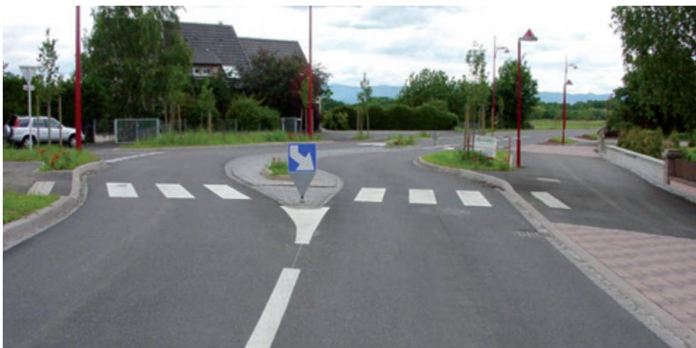
Chicane ovoïde limitant la vitesse des VL à 30 km/h, et permettant le passage des poids lourds à la vitesse du pas.
